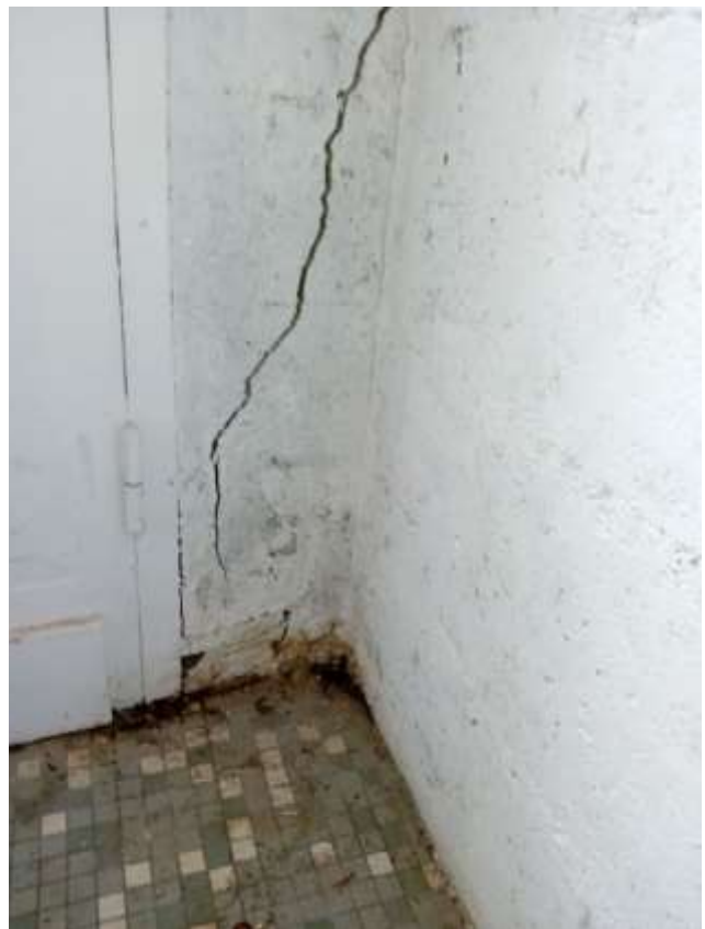
Fissure oblique traversante entre la porte arrière et le refend.
