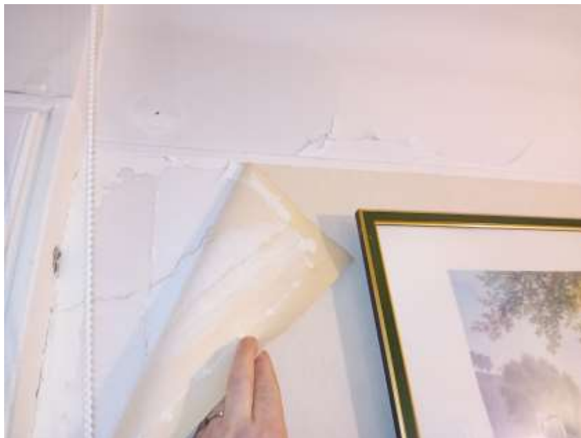
Fissure oblique traversante à l'angle de la fenêtre à l'étage.
